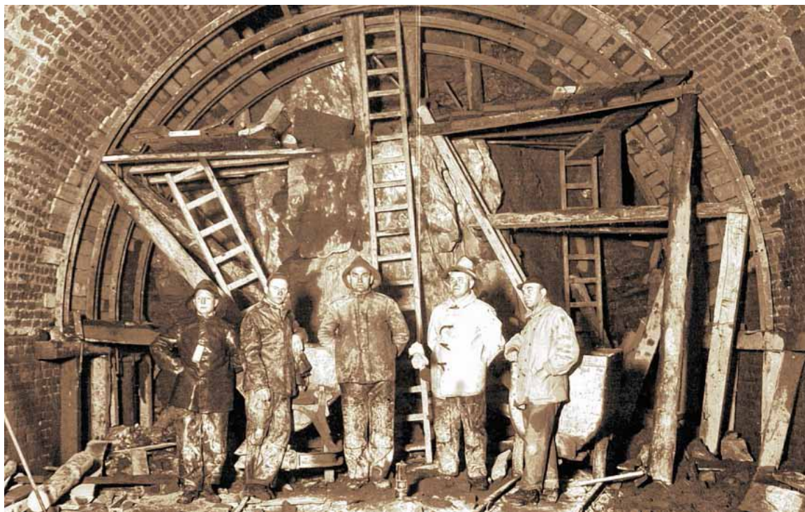
Streckenvortrieb am Schacht Norddeutschland 1925: Noch immer sind zahlreiche alte Schächte unentdeckt.
